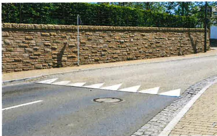
Plateau et revêtement clair sur un tronçon limité à 30 km/h
